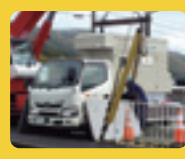
B 消防用発電機 更新・メンテナンス
