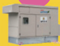
C BCP用発電機新設
