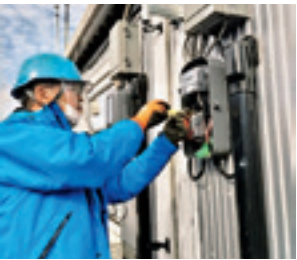
仮設住宅の竣工検査（電力量計点検）
