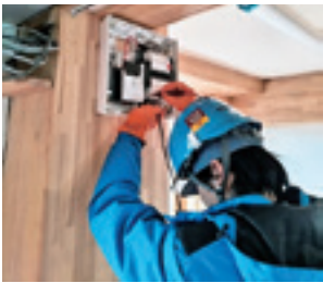
仮設住宅の竣工調査（絶縁抵抗測定）
