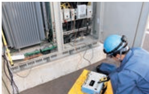
絶縁監視装置の動作試験
