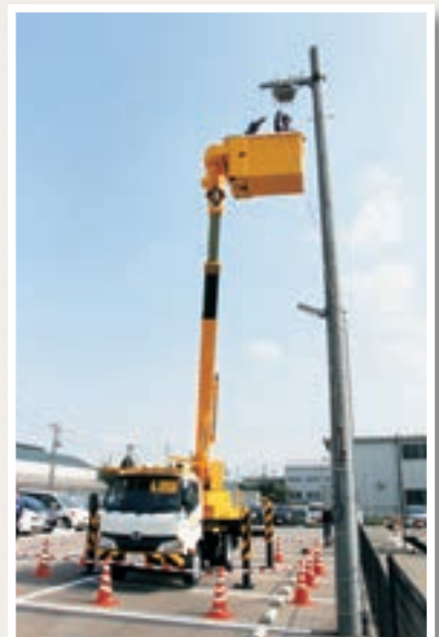
写真④高所作業車の導入
