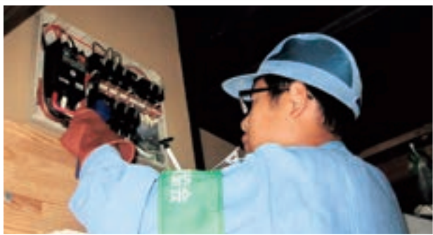
分電盤の点検
