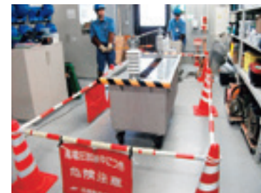
写真1：絶縁ゴム手袋耐電圧検査のようす
