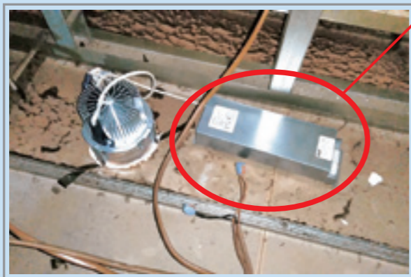
LED照明器具 (不良器具を回路から切り離した後)
